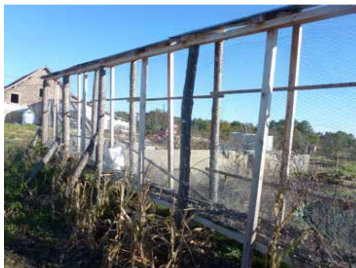
Crib en bois et grillage .
